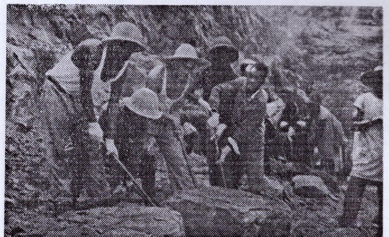
Ces travailleurs chinois et guinéens que l'on voit ici en plein labeur, ce sont quelques uns de ceux qui ont réalisé le barrage de Kinkon dans le Fouta-Djallon.
